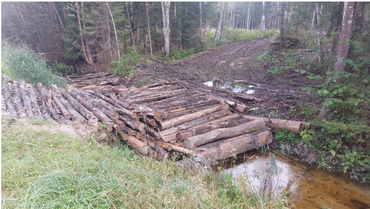
Foto 11. Ajutine ülepääs ehitatava Orumetsa tee alguses Hauginiidu ojal (25.09.2025)
